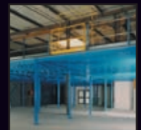
Plate-forme de stockage
